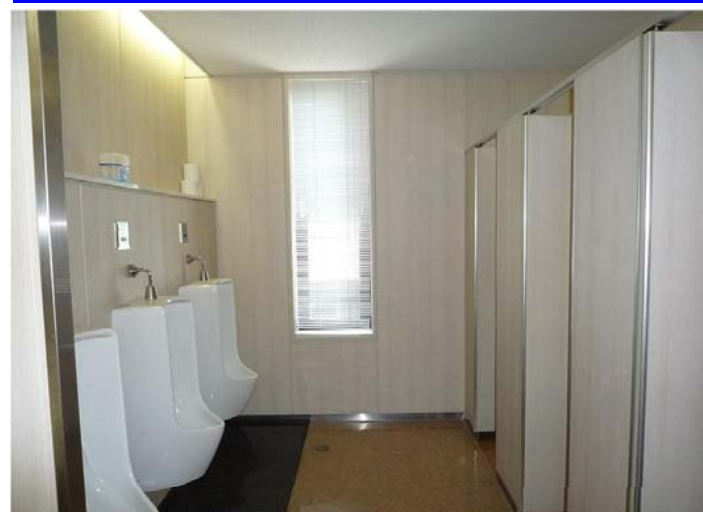
男性トイレ（改修前）：小便器スペース
