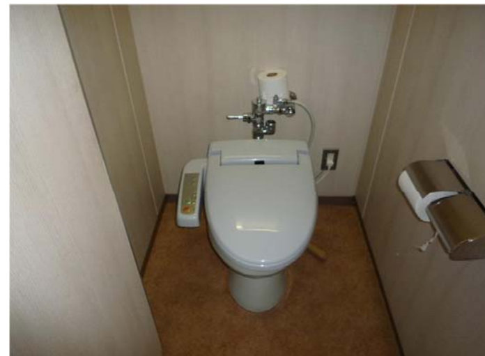
女性トイレ（改修前）：大便器スペース
