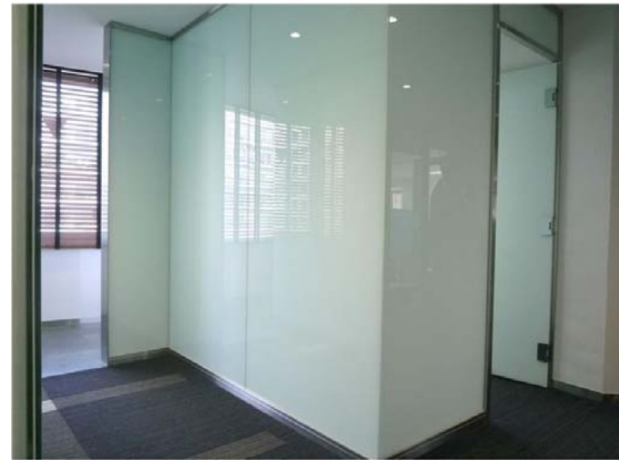
シートをサンドイッチしたガラス製のパーティションにより、透過性をコントロールしつつ、ガラスの透明感による意匠性と両立している。
