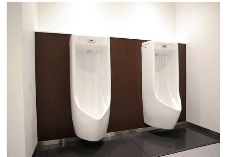
大便器同様自動洗浄対応の器具を選定し節水性を確保すると共に奥行きのあるライニングを採用し、手荷物に配慮した。
