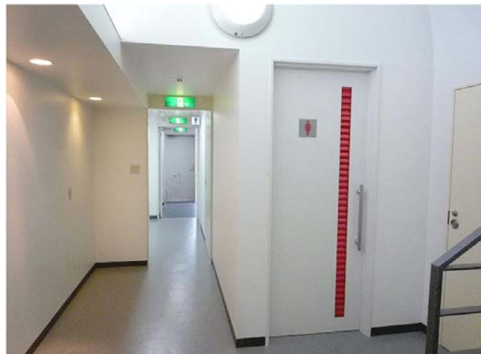
防火区画に面する女性トイレ入り口と避難経路に面する男性トイレ入り口。
