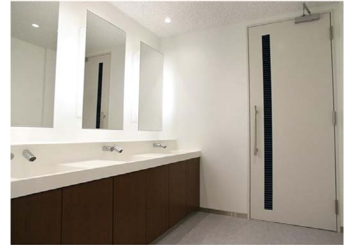
発電タイプの自動水栓とすることで停電時の利用も可能。水石けん入れも非接触で利用できるものを採用した。
